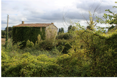
Une vue depuis la route. Phot. Pierrick Barreau IVR54_20171709755NUCA
