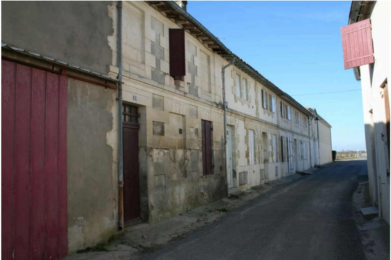
Vue d'ensemble des logements d'ouvriers.
