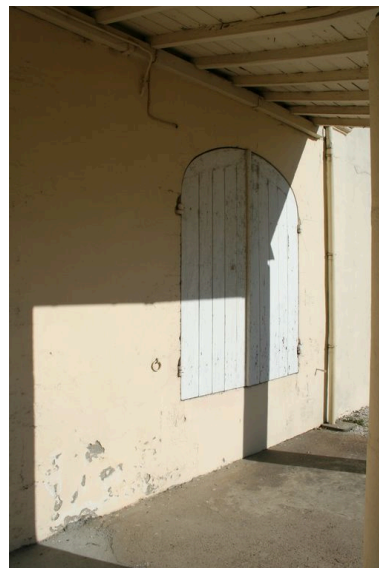
Ancien cuvier : baie de décharge. Phot. Claire Steimer IVR72_20123303484NUCA
