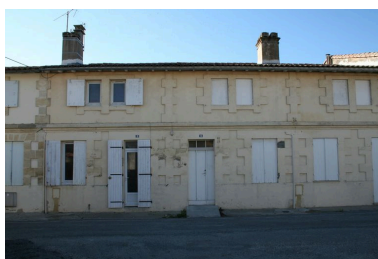
Logements d'ouvriers : détail des façades. Phot. Claire Steimer IVR72_20123303480NUCA
