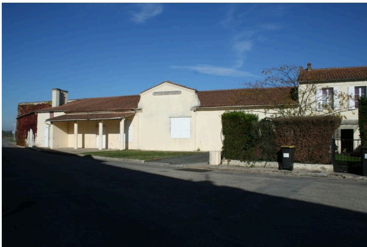
Ancien cuvier et logements : vue d'ensemble.
