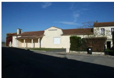
Ancien cuvier et logements : vue d'ensemble. Phot. Claire Steimer IVR72_20123303485NUCA
