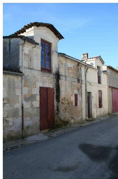
Logements et dépendances. Phot. Claire Steimer IVR72_20123303478NUCA
