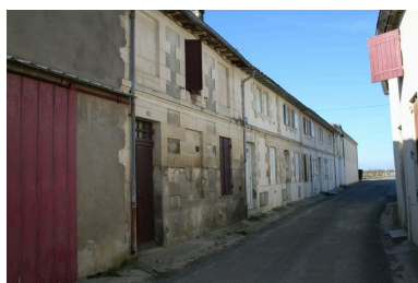
Vue d'ensemble des logements d'ouvriers. Phot. Claire Steimer IVR72_20123303479NUCA
