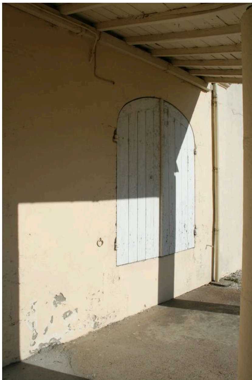
Ancien cuvier : baie de décharge.
