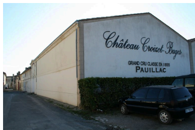
Vue d'ensemble. Phot. Claire Steimer IVR72_20123303482NUCA
