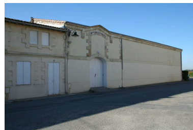
Bâtiments de stockage : (anciens chais ?). Phot. Claire Steimer IVR72_20123303481NUCA
