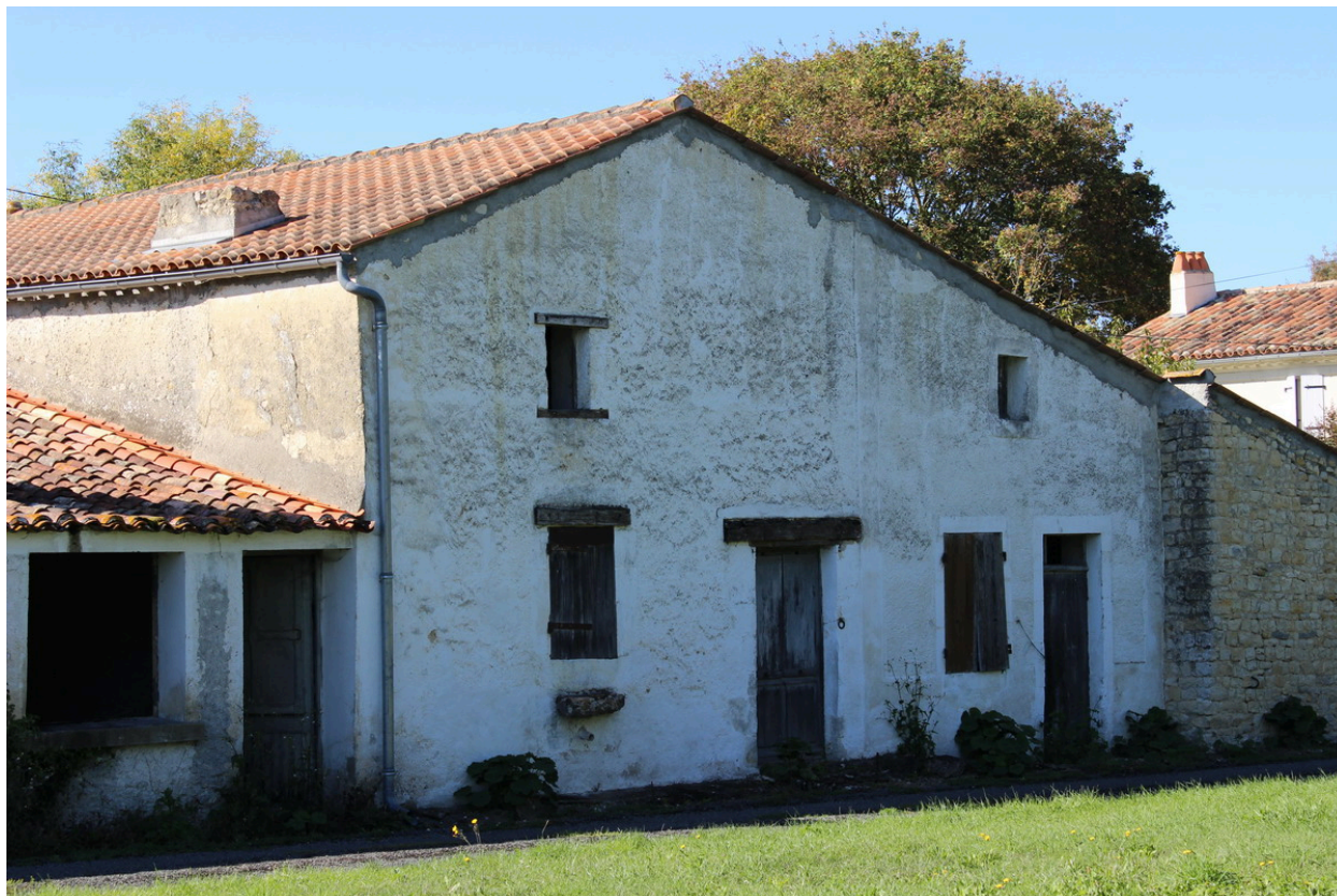
Une vue des deux maisons, depuis le sud-est.
