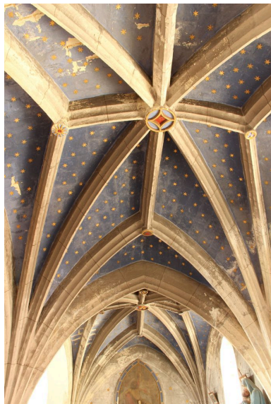
Vue d'ensemble de la voûte depuis l'ouest. Phot. Jean-Philippe Maissonave IVR72_20144000922NUC2A
