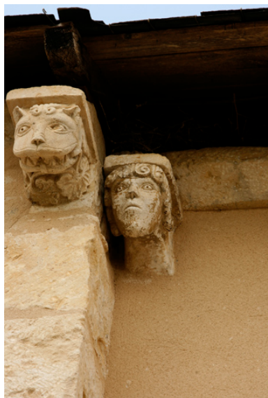
Abside, élévation sud, modillons : dernier modillon de la travée droite (tête de lion) et premier modillon de l'abside (tête humaine). Phot. Raphaël Jean IVR54_20098600064NUCA
