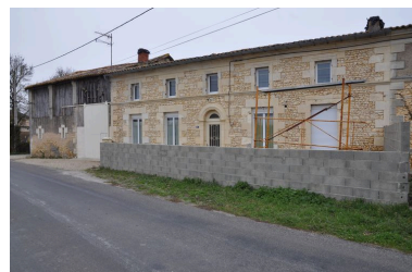
Façade principale. Phot. Claire Steimer IVR72_20113300059NUCA
