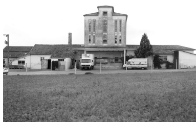
Vue d'ensemble prise du nord. Phot. Marc Deneyer IVR54_19961701532V
