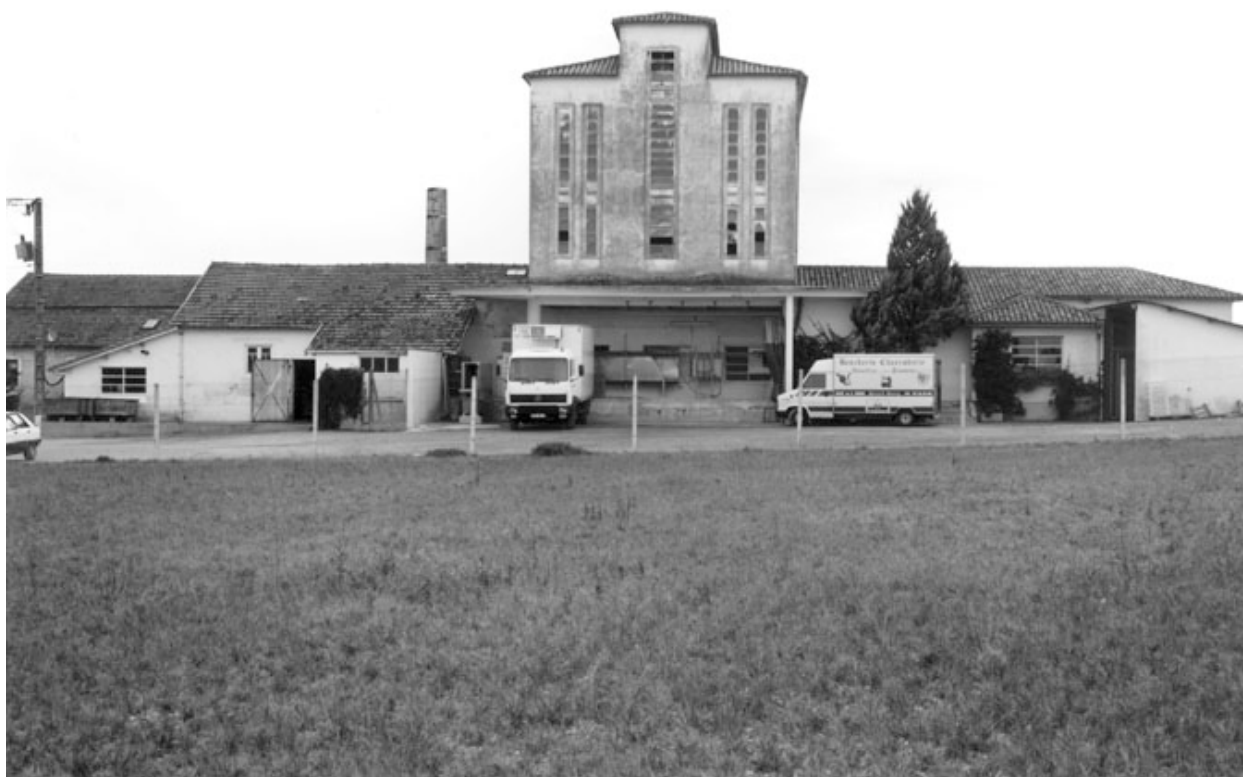
Vue d'ensemble prise du nord.
