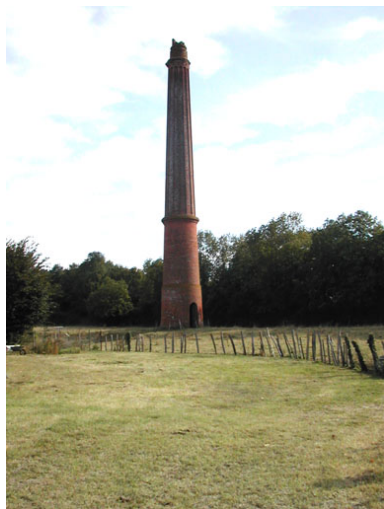
Vestiges du four Hoffmann de l'usine de chaux Briffaud, à Coulonges-sur-l'Autize. Phot. Pascale Moïsdon
