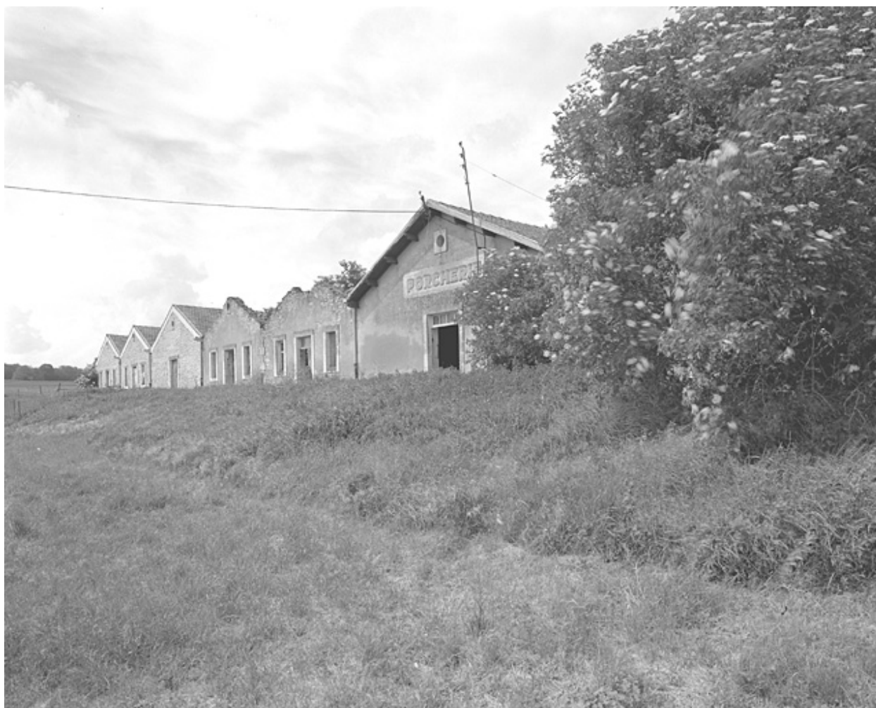
Ensemble des bâtiments de la porcherie vus du sud est.
