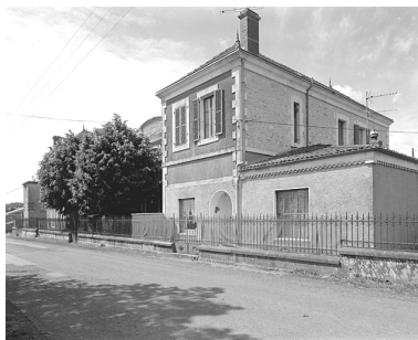
Bâtiment principal (beurrerie et logements) vu du sud est. Phot. Marc Deneyer IVR54_19971700873V
