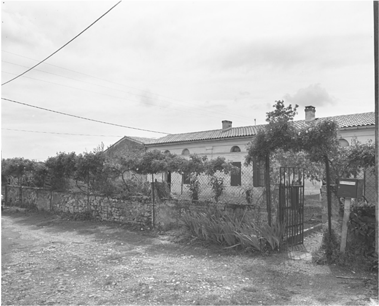
Elévation antérieure des logements d'ouvriers situés à l'ouest de la laiterie.
