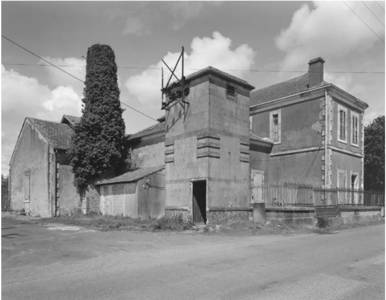
Vue prise du sud ouest : caséinerie, transformateur et logement du directeur.
