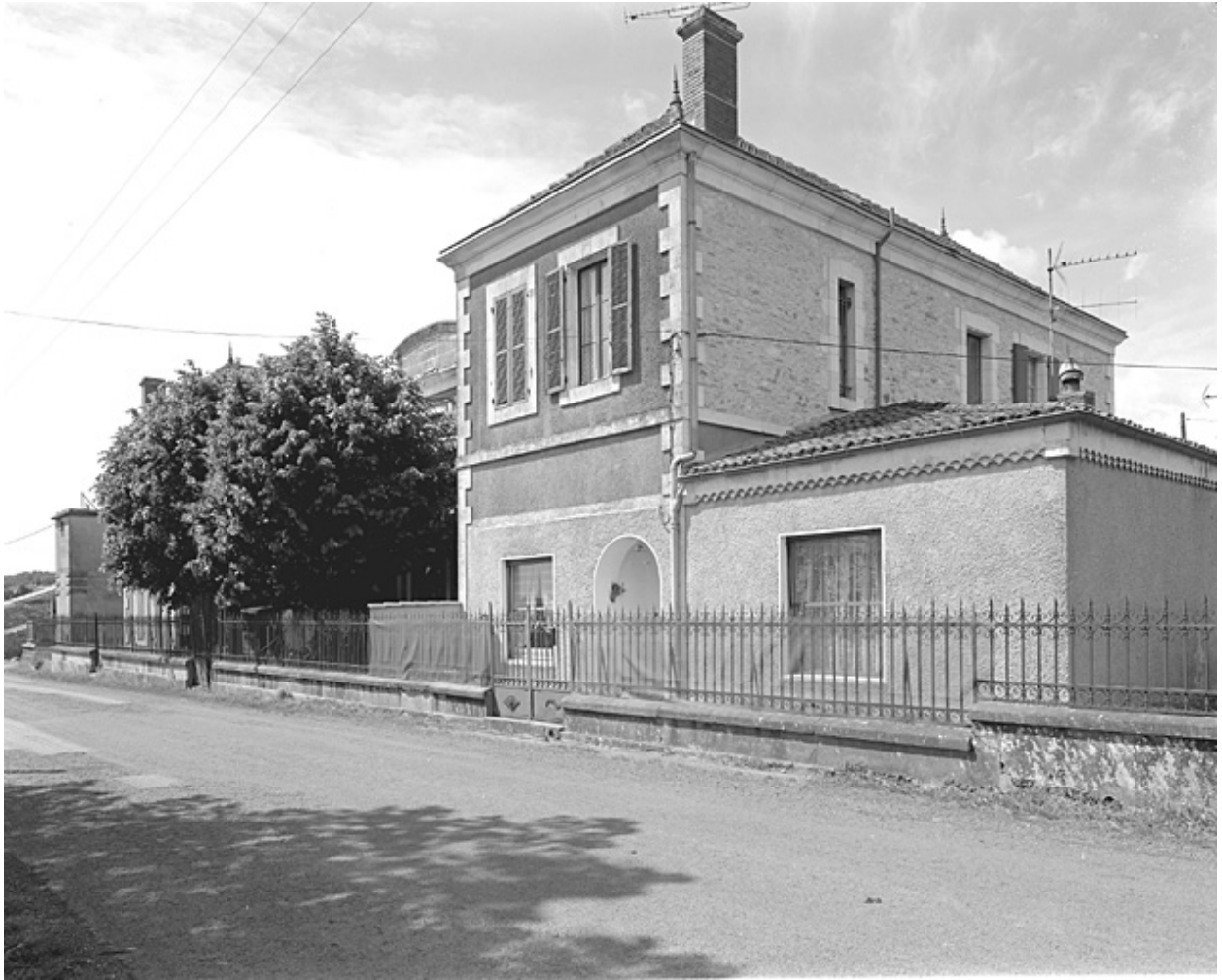
Bâtiment principal (beurrerie et logements) vu du sud est.
