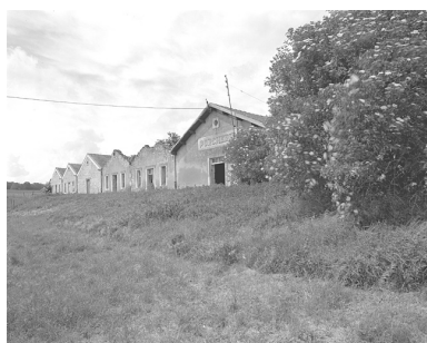
Ensemble des bâtiments de la porcherie vus du sud est. Phot. Marc Deneyer IVR54_19971700875V
