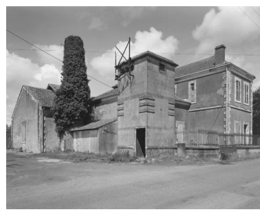
Vue prise du sud ouest : caséinerie, transformateur et logement du directeur. Phot. Marc Deneyer IVR54_19971700874V
