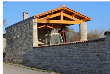
Le hangar à piles maçonnées cylindriques, depuis le sud-est. Phot. Nathalie Lhuissier IVR54_20171700390NUCA
