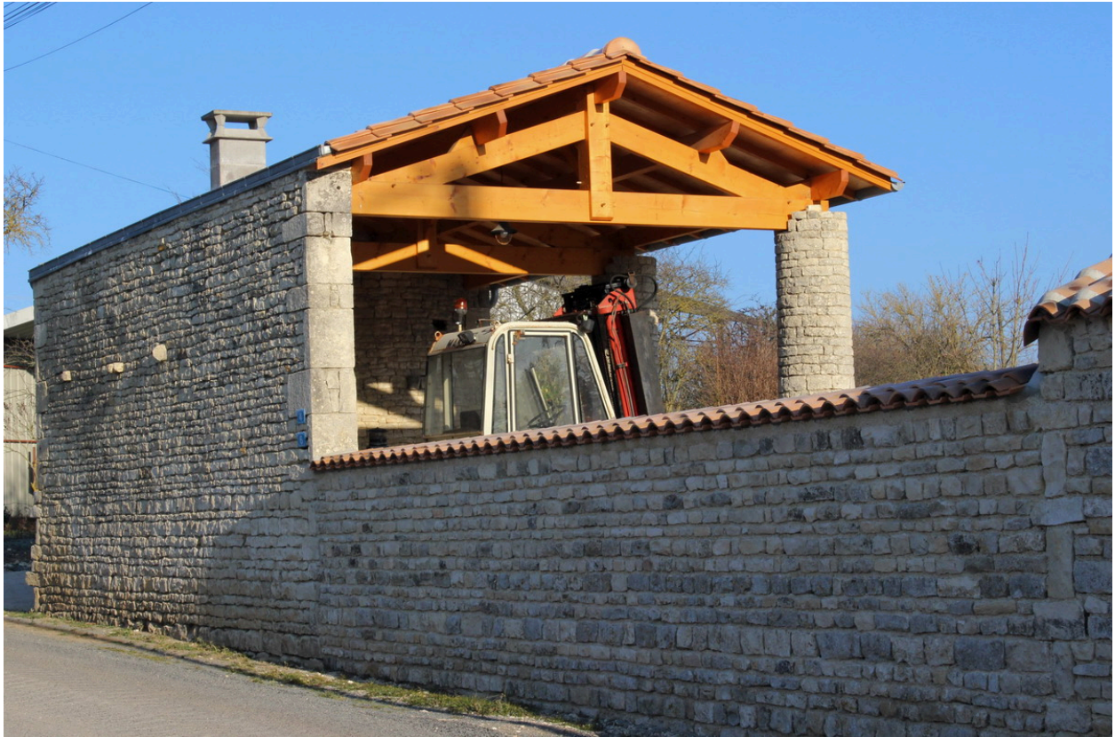
Le hangar à piles maçonnées cylindriques, depuis le sud-est.
