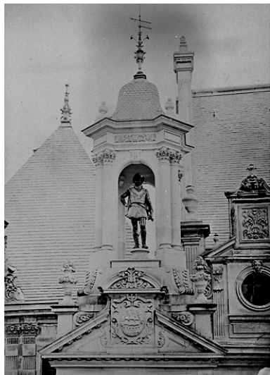
Corps principal, escalier sur cour, partie supérieure, en 1878. Photographie de l'Album Cognacq. Phot. Alain Maulny IVR54_19921703087X
