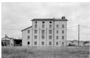
Vue générale prise du nord ouest. Phot. Marc Deneyer IVR54_19961700587V
