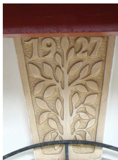
Détail du faux claveau sculpté d'un arbre. Phot. Maïté Ehlinger IVR72_20206401636NUC2A
