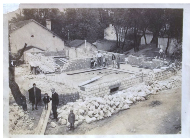
Photographie de la construction de la maison vers 1935 (collection Jacques Descamp). Repro. Yannis Suire IVR54_20151710902NUCA
