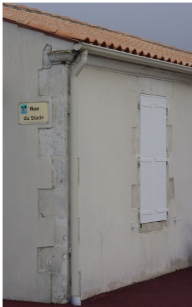
Détail sur un chaînage d'angle. Phot. Yann Cussey IVR54_20051702956NUCA
