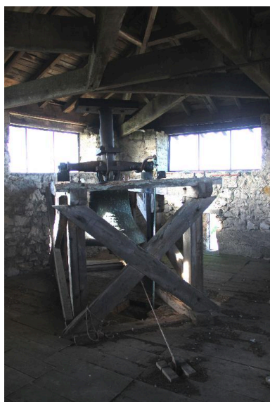
Vue de la cloche dans son beffroi charpenté. Phot. Jean-Philippe Maisonnave IVR72_20174001149NUC2A
