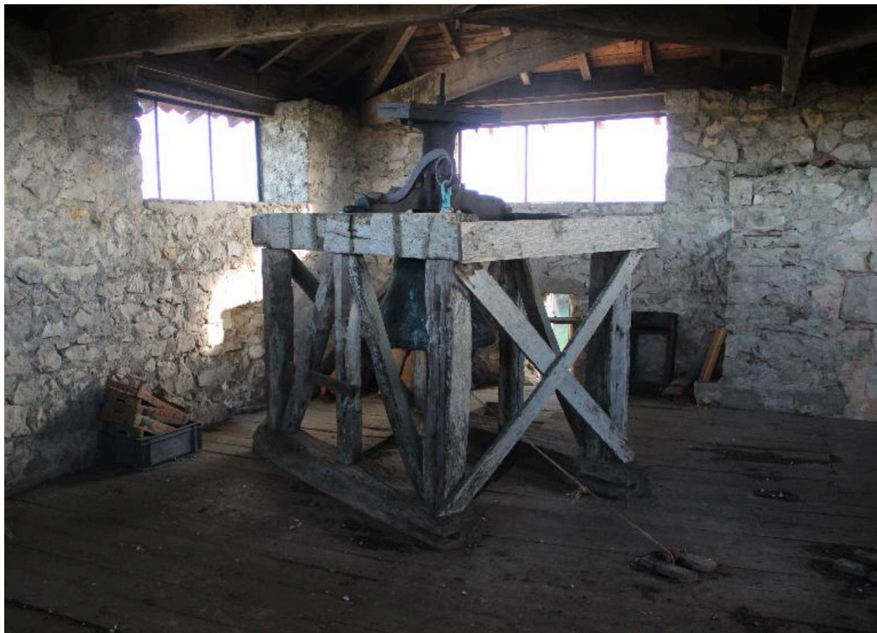
Vue de la cloche dans son beffroi charpenté.
