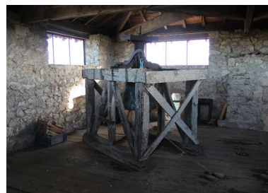
Vue de la cloche dans son beffroi charpenté. Phot. Jean-Philippe Maisonnave IVR72_20174001148NUC2A
