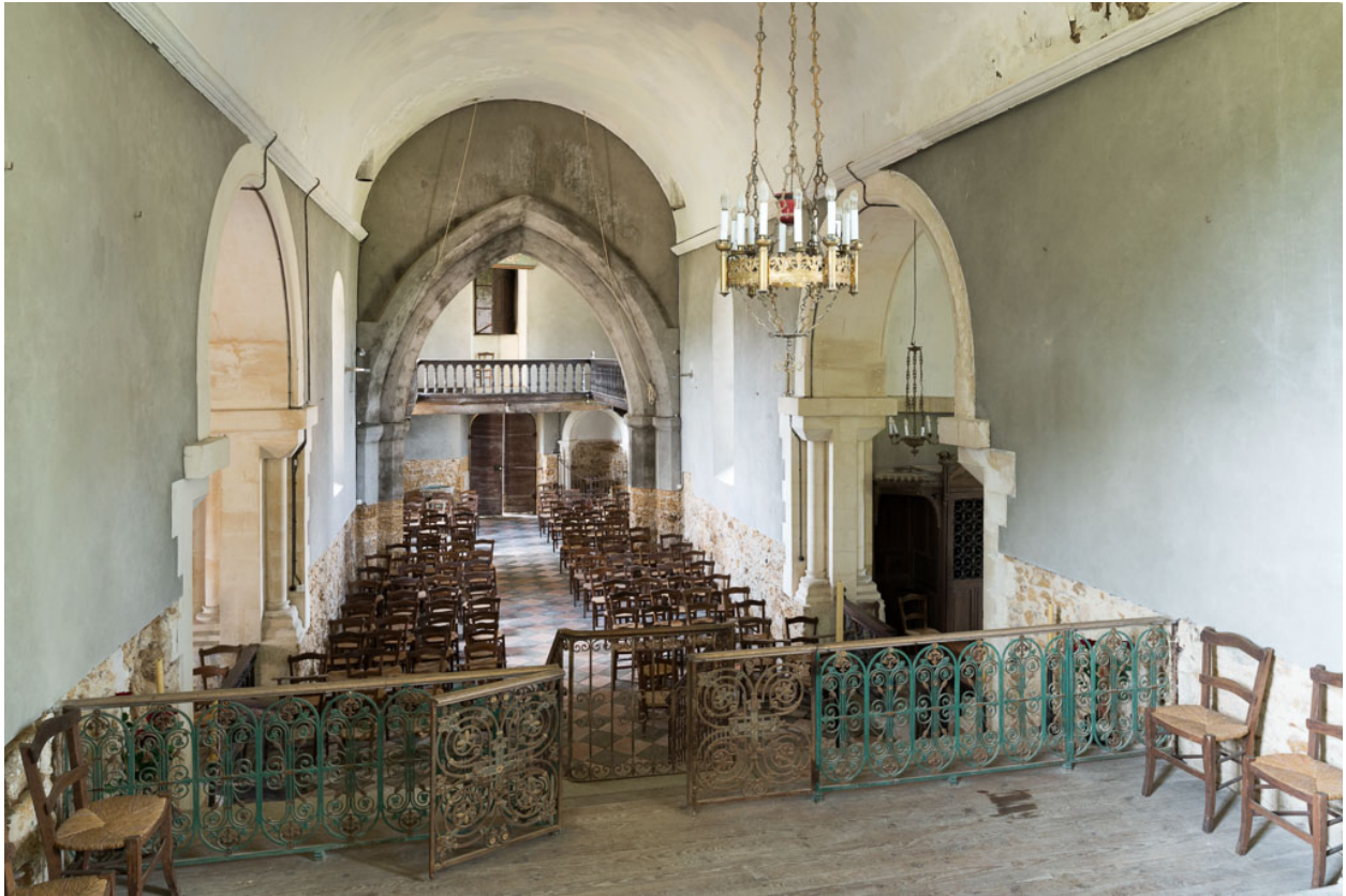
Ensemble de la clôture vue depuis le chœur.
