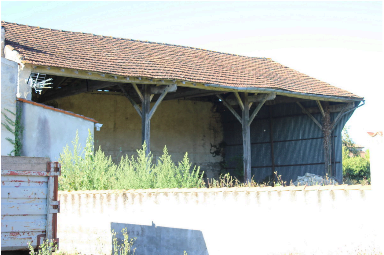
Une vue du hangar adossée, depuis le nord-est.
