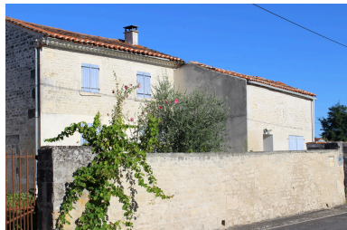
Une vue du logement et de la dépendance accolée, depuis le sud-est.
