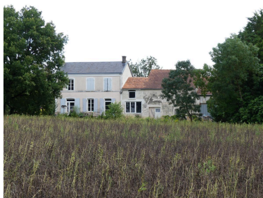
Façade orientée au sud. Phot. Océane Charruyer IVR75_20211705793NUCA
