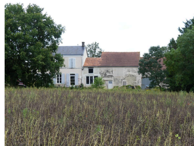
Façade orientée au sud. Phot. Océane Charruyer IVR75_20211705792NUCA
