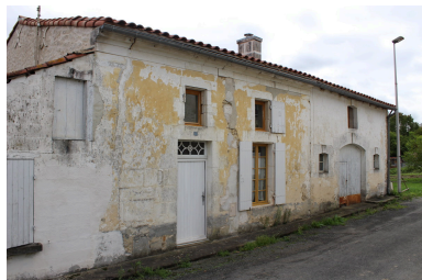
Une vue d'ensemble. Phot. Pierrick Barreau IVR54_20171709782NUCA
