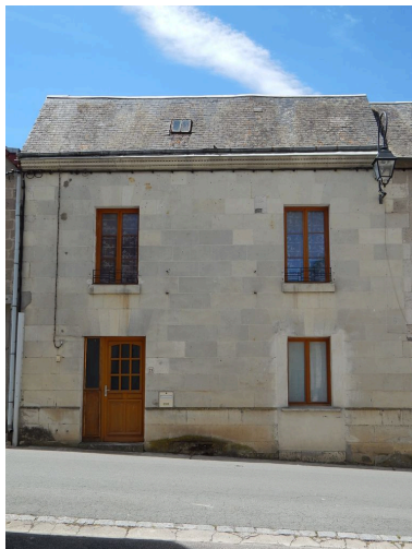
Élévation occidentale de la maison. Phot. Paul Maturi IVR75_20188608404NUCA
