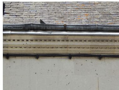
Corniche à denticules de la maison. Phot. Paul Maturi IVR75_20188608405NUCA
