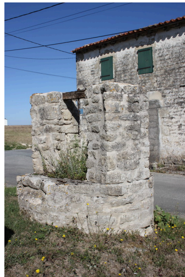
Une autre vue du puits, depuis le sud-est. Phot. Nathalie Lhuissier IVR75_20191702342NUCA
