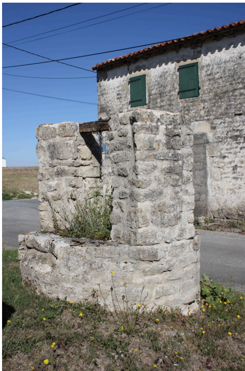
Une autre vue du puits, depuis le sud-est.
