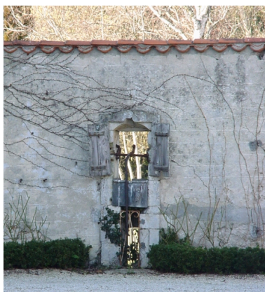
Vue d'un puits encastré dans un mur de clôture, avenue Louise Pinchon. Phot. Yann Cussey IVR54_20061702420NUCA
