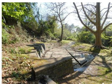
Vue de la fontaine et de la promenade. Phot. Maïté Ehlinger IVR72_20186401995NUC2A
