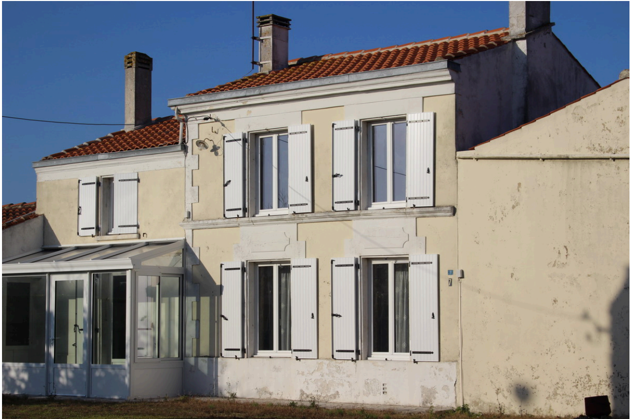
Une vue rapprochée du logement de l'ancienne ferme, depuis le sud-est.
