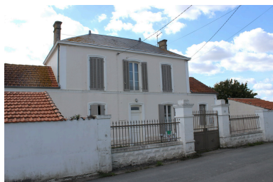
Une vue de l'école, depuis le sud-est. Phot. Nathalie Lhuissier IVR54_20171701120NUCA
