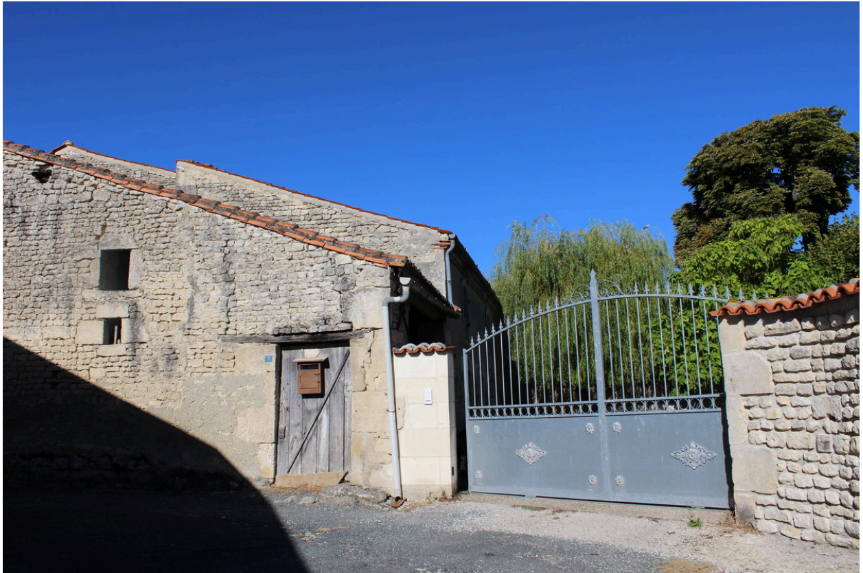
Une vue partielle des dépendances de l'ancienne ferme, depuis l'est.
