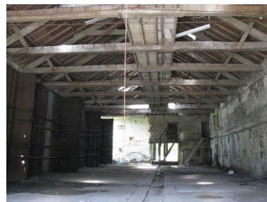
Intérieur du bâtiment principal. Phot. Yannis Suire IVR54_20121704915NUCA
