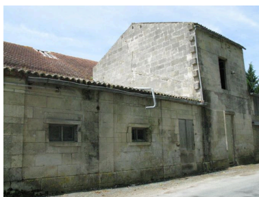
Les bâtiments le long de la rue de l'Uzet. Phot. Yannis Suire IVR54_20121704906NUCA
