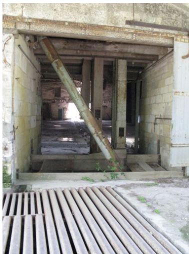
Vue depuis le hangar au nord. Phot. Yannis Suire IVR54_20121704907NUCA
