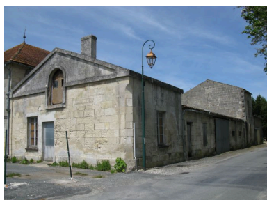
Les bâtiments le long de la rue de l'Uzet. Phot. Yannis Suire IVR54_20121704902NUCA
