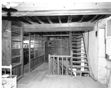
Premier étage de l'atelier de fabrication. Phot. Alain Dagorn IVR54_19991701707V
