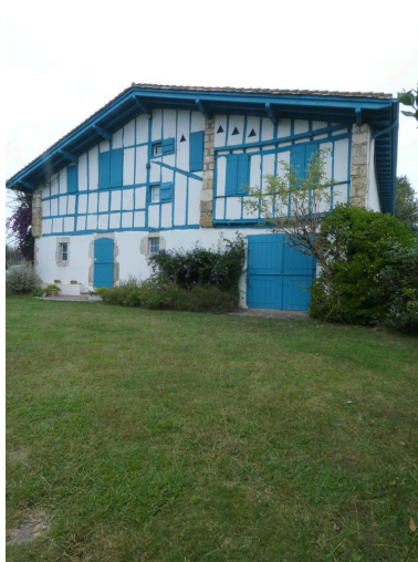
Maison Hirigoiena Phot. Maïté Ehlinger IVR72_20196403062NUC2A
