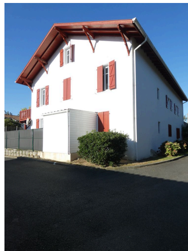
Maison Jauregia, aujourd'hui immeuble à logements. Phot. Maïté Ehlinger IVR72_20196403905NUC2A
