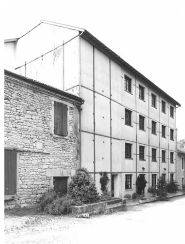
Vue de l'atelier de fabrication prise du sud-ouest. Phot. Alain Dagorn IVR54_19991701711V
