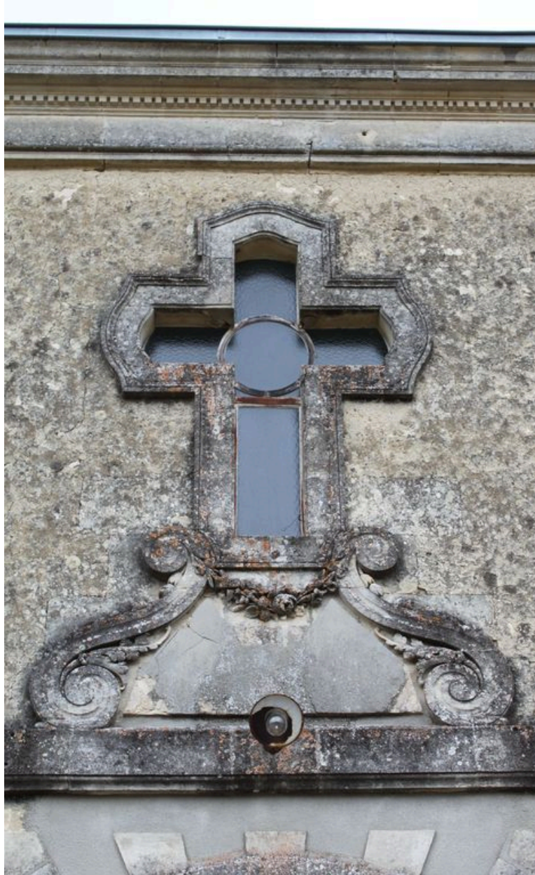
Détail de la baie en forme de croix.
