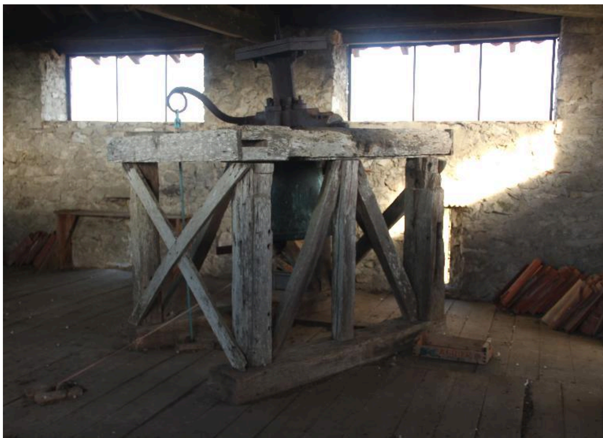
Vue de la cloche dans son beffroi charpenté.
