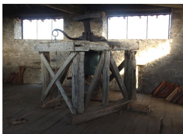
Vue de la cloche dans son beffroi charpenté. Phot. Jean-Philippe Maisonnave IVR72_20174001146NUC2A
