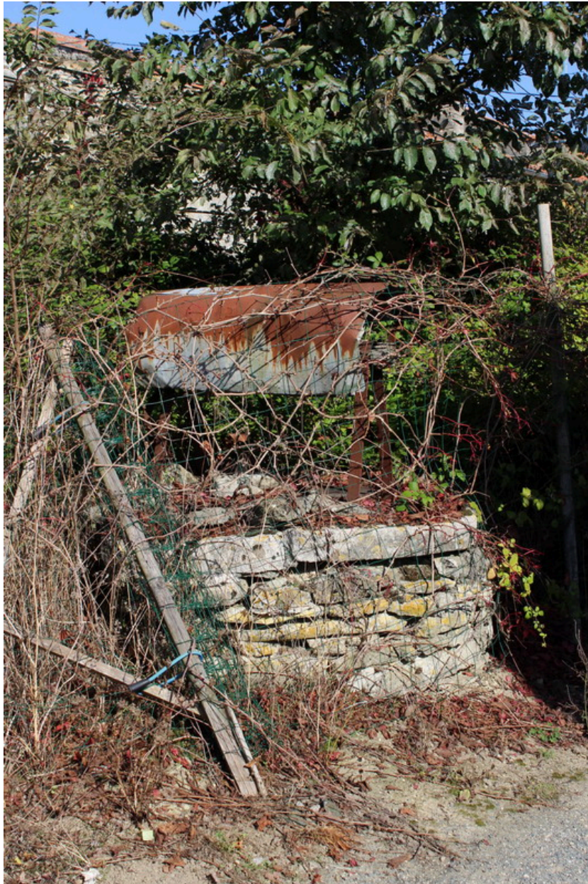
Une vue du puits, depuis l'ouest.
