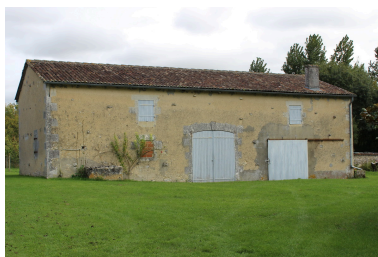
Les dépendances dans la cour. Phot. Pierrick Barreau IVR54_20171709807NUCA
