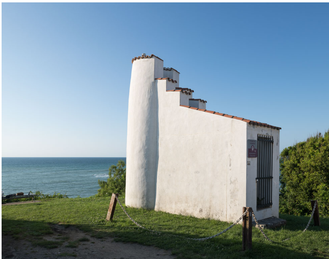
Vue de l'ancienne tour de guet depuis le sud.
