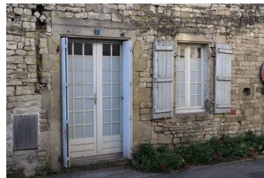
Un détail du rez-de-chaussée. Phot. Pierrick Barreau IVR54_20161710316NUCA
