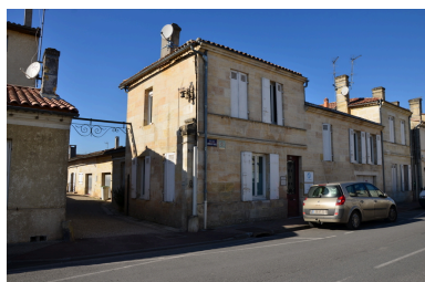
Vue d'ensemble. Phot. Florian Grollimund IVR72_20153301294NUC2A
