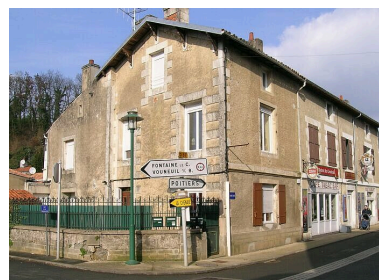
Élévations sud et est. Phot. Geneviève Renaud IVR54_20078600288NUCA
