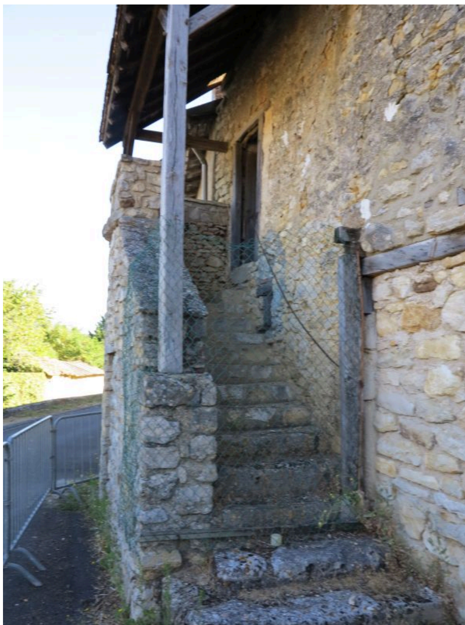
Escalier extérieur, vu depuis le sud.
