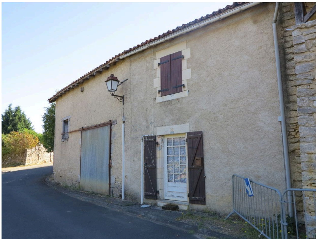
A droite, maison du 10 rue du Petit-Ruisseau, à gauche la grange dépendant de l'ancien presbytère.
