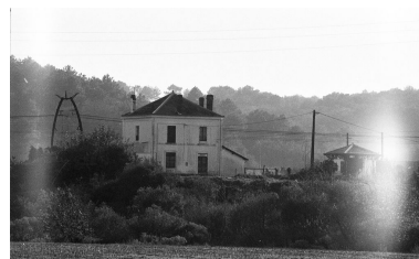
Vue de la gare depuis le nord-est, vers 1990. Phot. Pierre-Jean Harté-Lasserre IVR72_19996400140Z
