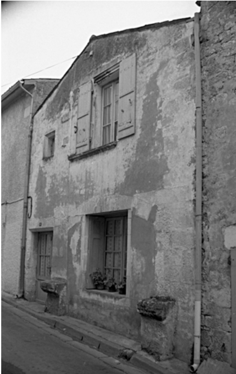
Une vue de la maison, depuis le nord-ouest, 1991.
