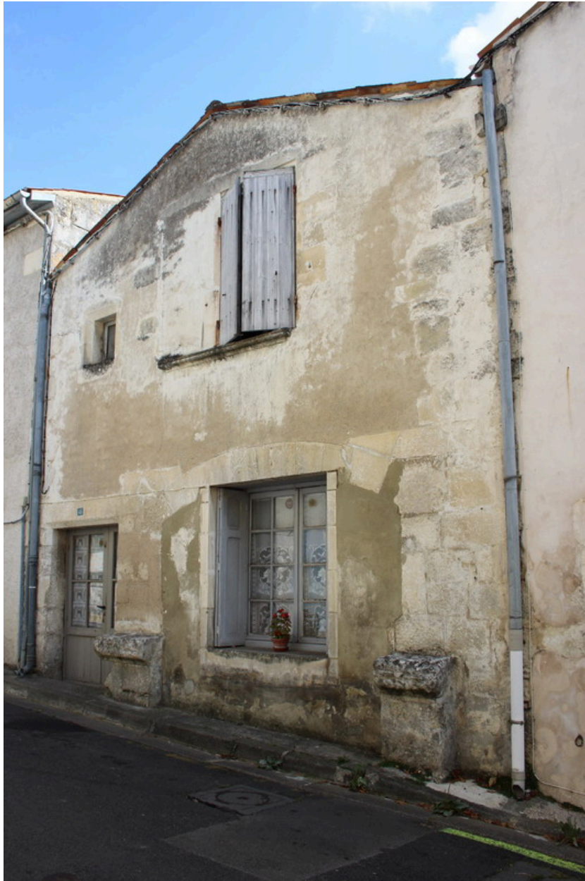
Une vue de la maison, depuis le nord-ouest.
