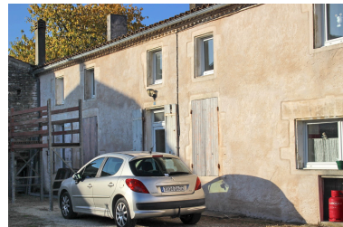
Une vue rapprochée des logements de l'ancienne ferme, depuis le sud-est. Phot. Nathalie Lhuissier IVR75_20191701611NUCA
