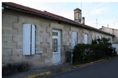
Façade des logements, côté rue de Lhorte. Phot. Claire Steimer IVR72_20123303131NUCA
