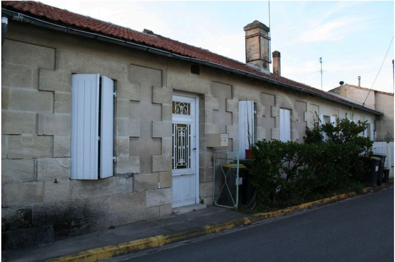
Façade des logements, côté rue de Lhorté.
