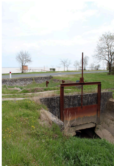
Détail de la pelle à crémaillère. Phot. Claire Steimer IVR72_20163301973NUC2A
