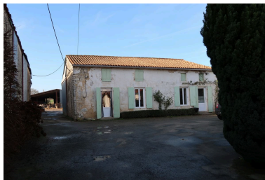
Vue générale de la façade principale. Phot. Mathilde Chemin IVR75_20187903240NUCA
