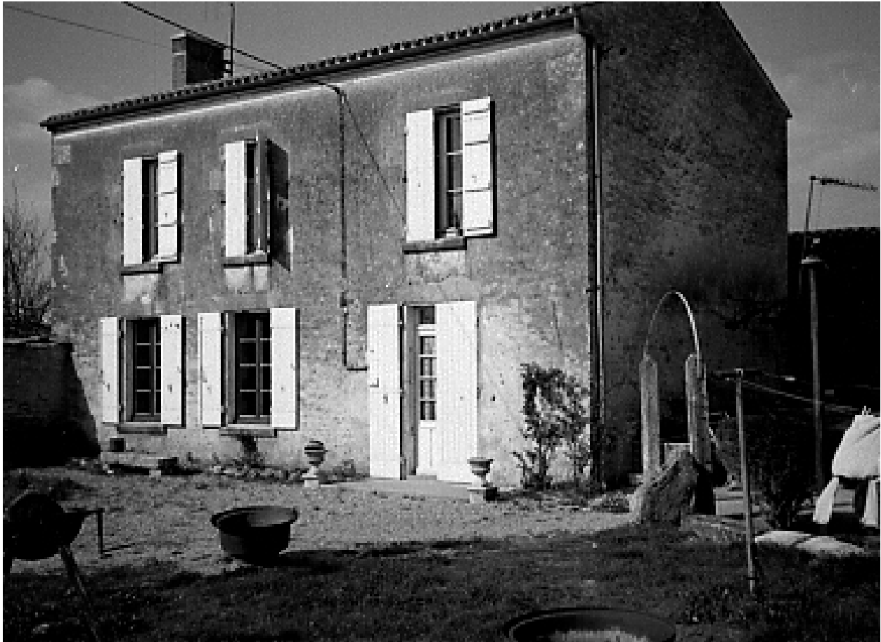
Une vue du logement.
