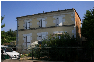
Le logement de l'ancienne ferme, depuis le sud-est. Phot. Pierrick Barreau IVR54_20131712520NUCA
