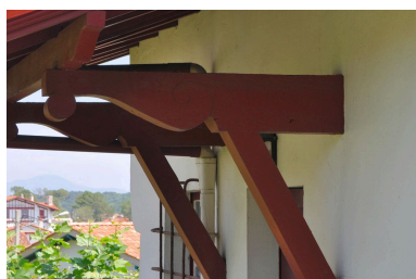
Détail de l'avant, façade nord. Phot. Maïté Ehlinger IVR72_20206401601NUC2A
