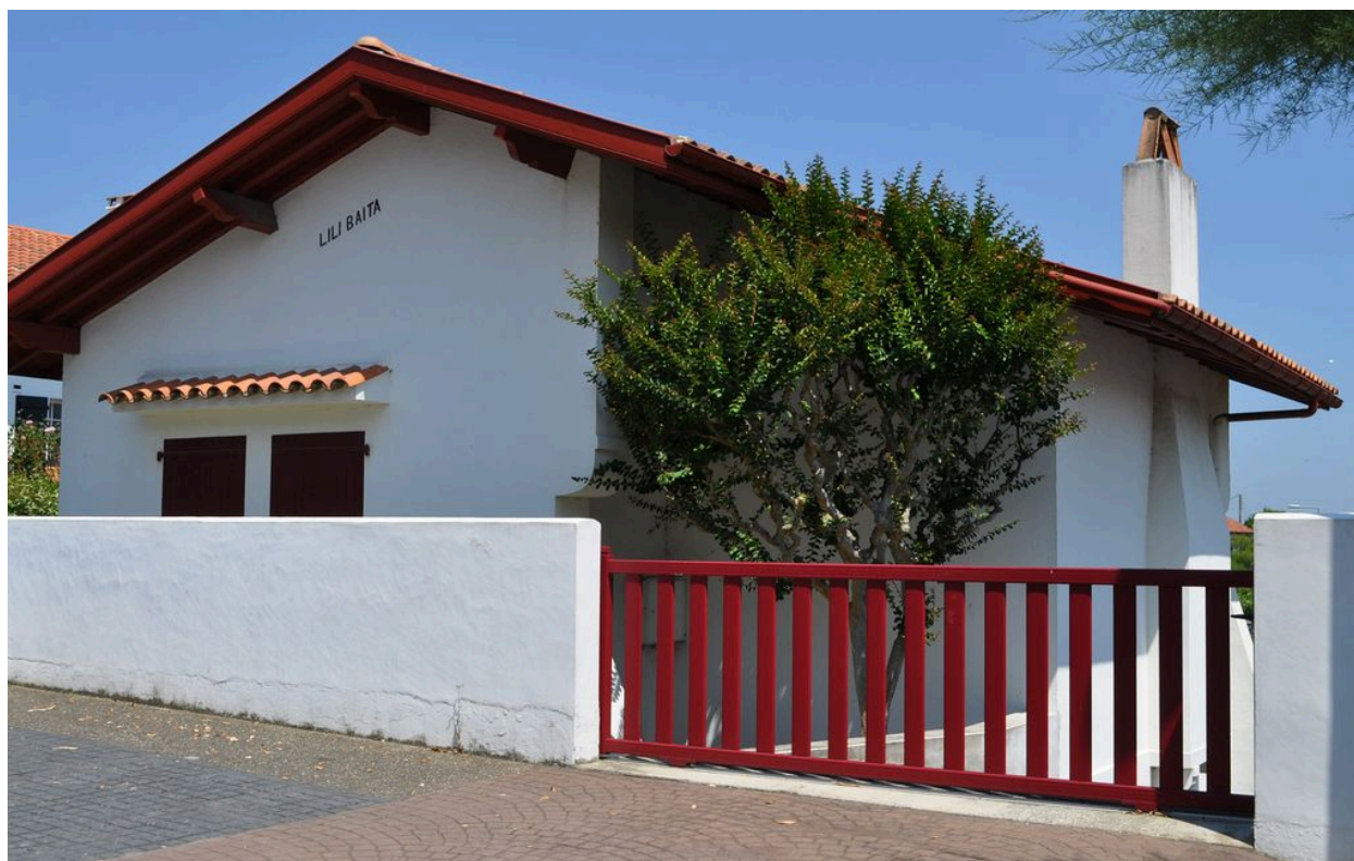
Vue de la façade sur rue (ouest).
