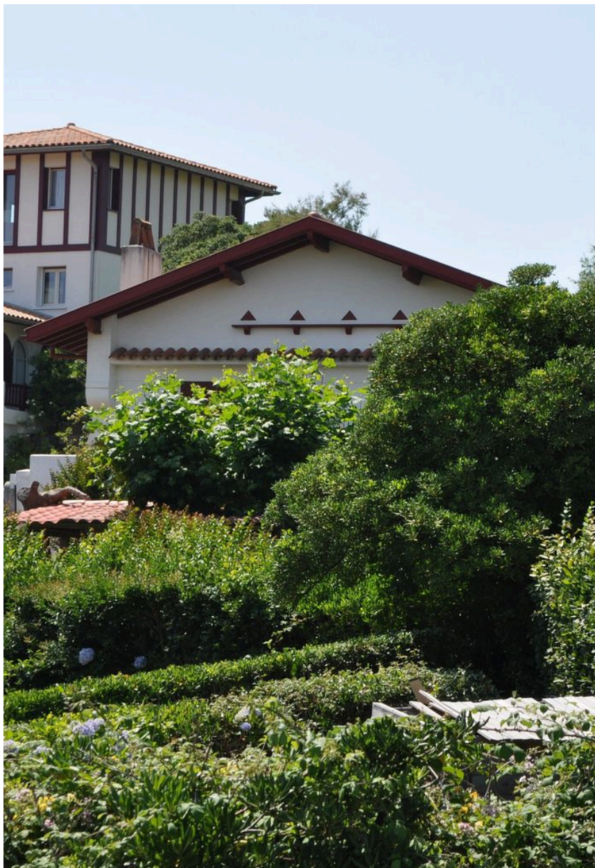
Vue de la façade est et du jardin.
