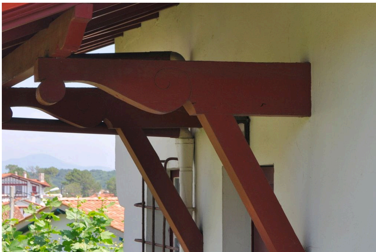
Détail de l'avant, façade nord.
