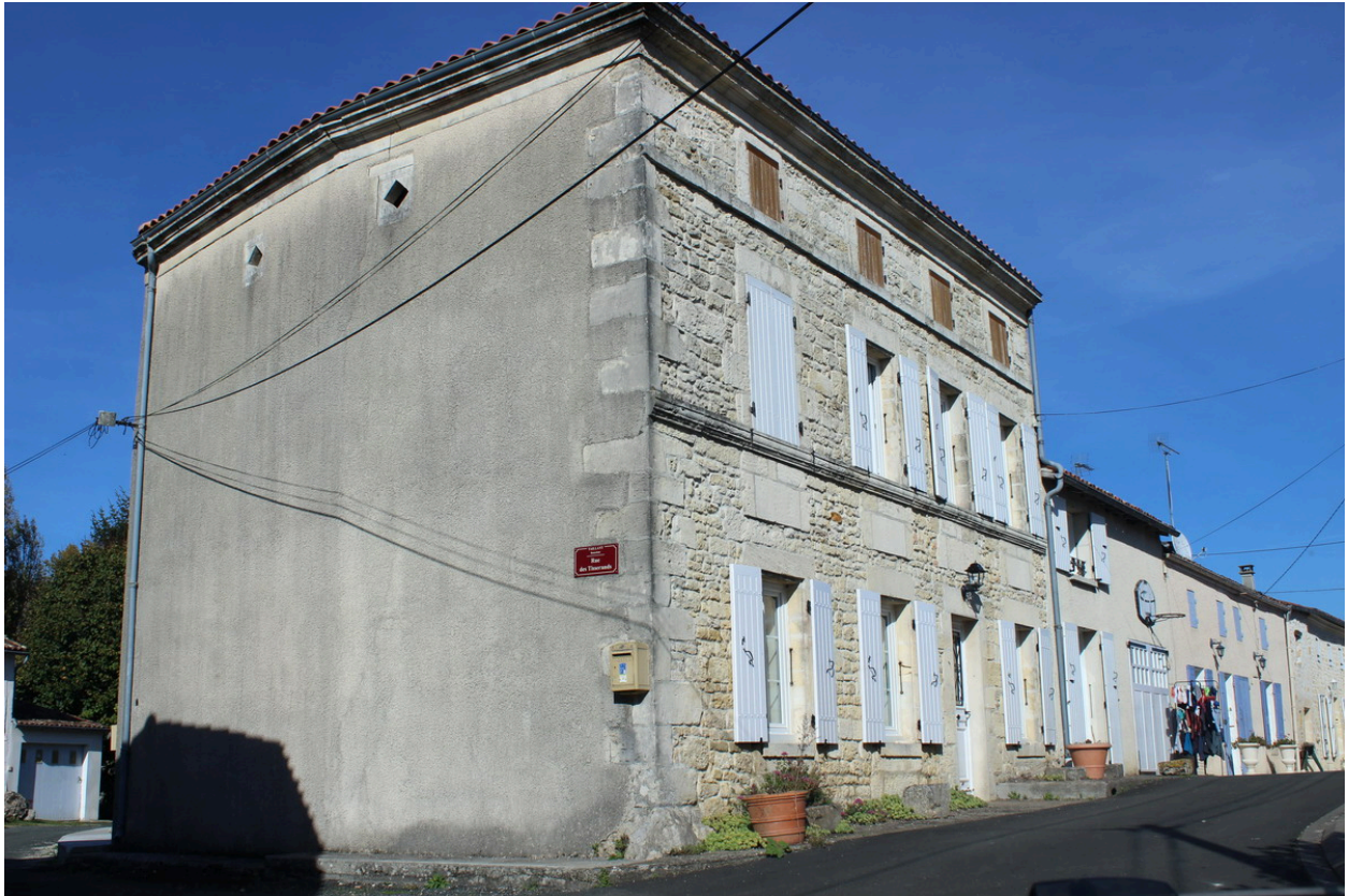
Une vue du logement de l'ancienne ferme, depuis le sud.
